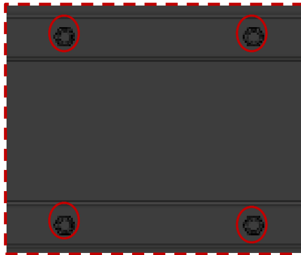
Abbildung 56 Inspektion der Gewindebohrungen
